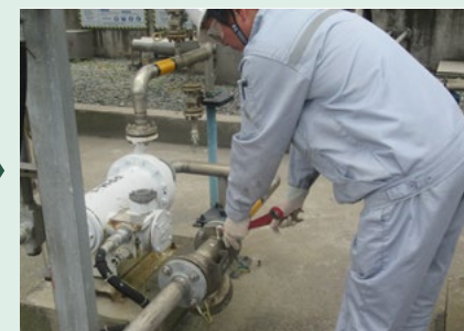
漏えい箇所の修理(Repair)
