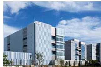
データセンタ（岡山第3センタ）
