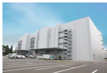
日立ハイテクノロジーズ ロジ製造棟
