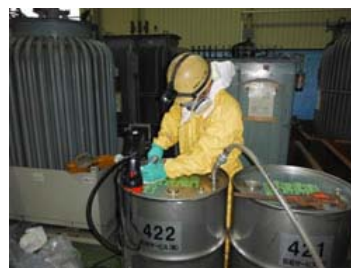
微量PCB汚染廃電気機器からの油抜き作業
