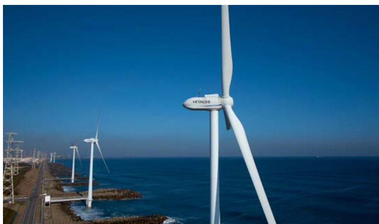
着床式の洋上風力発電所である「ウィンド・パワーかみす」（茨城県神栖市）では、日立製作所のダウンウィンド型風力発電設備（2,000kW）が15基稼働。15基の総発電出力はおよそ30,000kW。株式会社 ウィンド・パワー・いばらき ウィンド・パワーかみす第1洋上風力発電所
