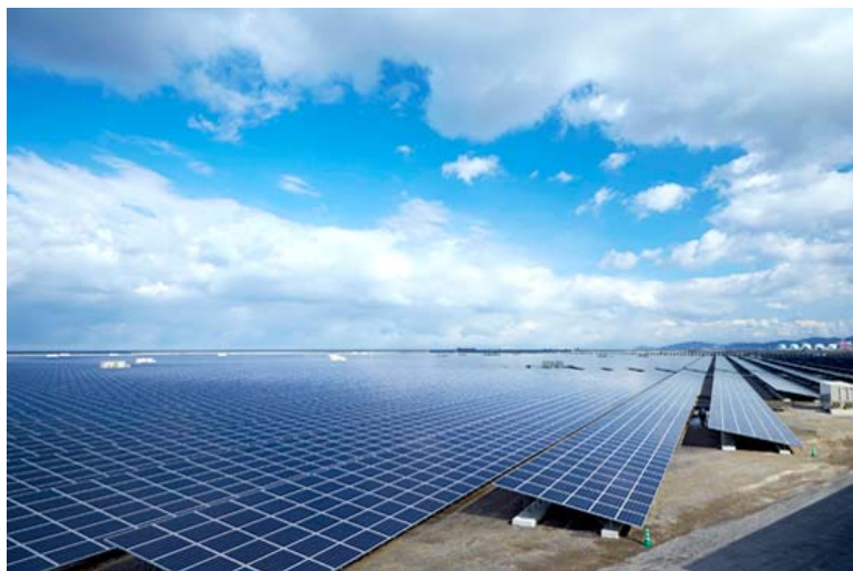
約105ヘクタールの土地に、太陽光パネル約34万枚を設置したメガソーラー（大分県大分市）。発電出力は8万2,020kWで、年間予想発電量は8,700万kWh（一般家庭年間消費電力約3万世帯分に相当*1）
