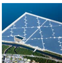
太陽光発電システム* 大分ソーラー パワー株式会社 大分ソーラーパワー (メガソーラー発電所)
