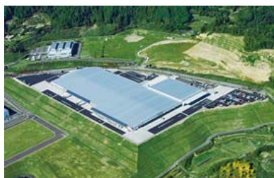
自然採光および太陽電池を導入した鳥栖第三物流センター
