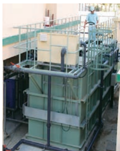
ドバイ市内レイバーキャンプ向け「ペルセウス」設備。約1,500人の生活排水を処理している
