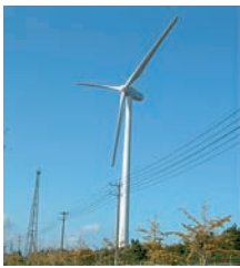
（左）富士重工業株式会社と共同開発した2,000kW風力発電設備
